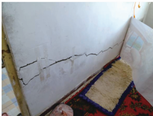
图1 定居房墙体裂缝
