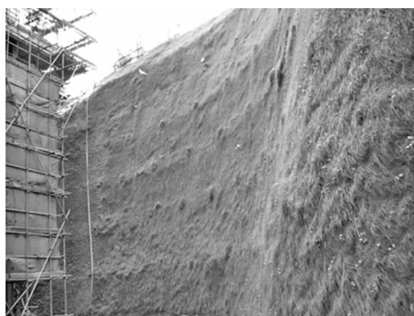
图2 挂网喷播坡面
